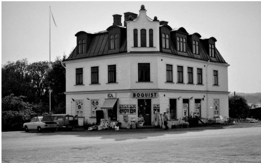
Slängom i Tösse. Huset byggdes av Anders Klevmarkens farfar.
